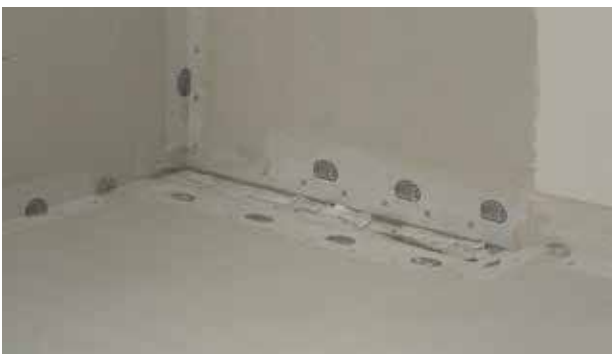
Alle båndene glattes sådan, at ARDEX SK 12 TRICOM-båndet er presset ned i membranen og der ikke er luftbobler og hulrum under båndet.
