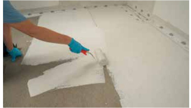
Når alle rørmanchetter og tætningsbånd er monteret, påføres første lag ARDEX vådrumsmembran med malerrulle på væggene i våd zone og hele gulvet.
