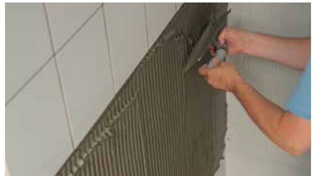
Når andet lag ARDEX tætningsmembran er tør, klæbes keramiske fliser eller natursten på underlaget med en egnet ARDEX fliseklæber. Alle ARDEX fliseklæbere kan anvendes ovenpå alle ARDEX vådrumsmembraner.
