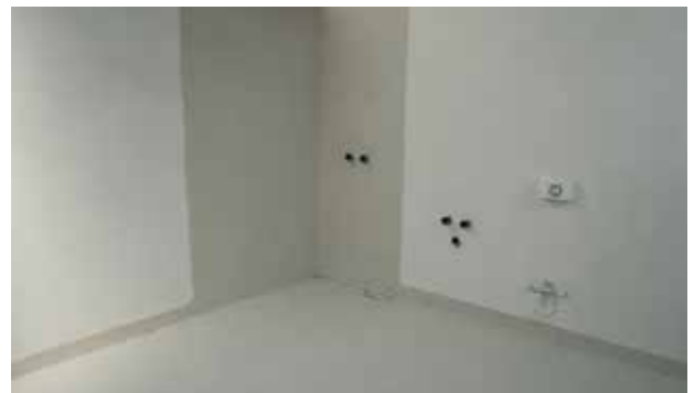
Når første lag membran er tør, påføres andet lag ARDEX tætningsmembran med malerrulle sådan, at både tætningsbånd og afløbsmåtte samt alle væg- og gulvflader er fuldt dækket.
