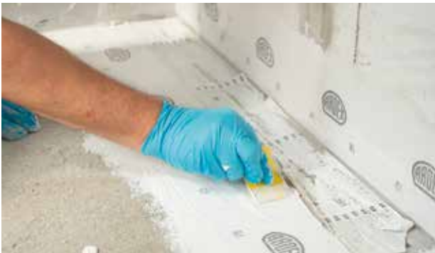
ARDEX SK TRICOM-båndet lægges i den våde og klæbrige membran sådan, at ca. halvdelen af båndet er placeret på stålflanchen og den anden halvdel er placeret på underlaget.
