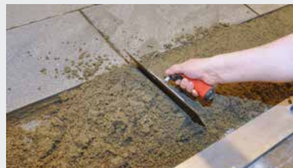
Jordfugtig ARDEX A 38 MIX fordeles ovenpå svumningen
