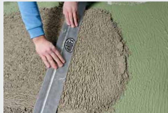
Støbning af gulv med ARDEX A 38 MIX
